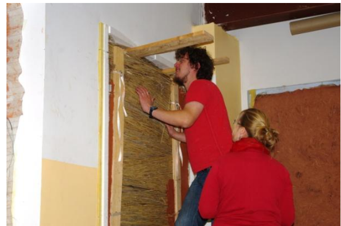
Joonis 3.12. Sein S2, soojustatud horisontaalselt asetatud lahtise pillirooga (foto: J. Miljan)
