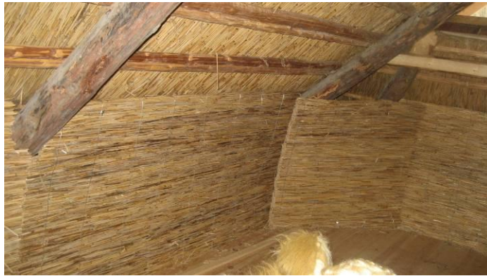
Joonis 3.43. Korralikult soojustatud pööning (foto: S. Sõber)
