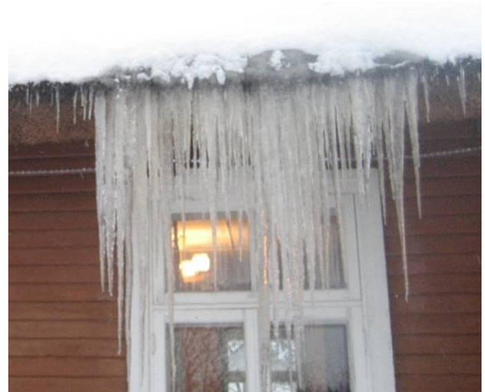
Joonis 3.44. Jääpurikad roogkatuse räästas (foto: S. Sõber)
