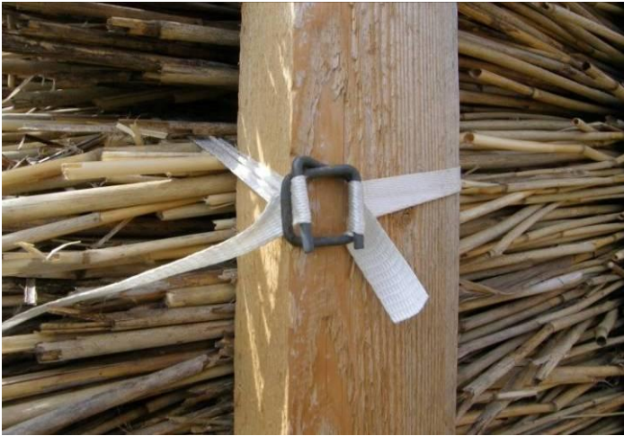
Joonis 3.22. Kokku pressitud roog fikseeriti postide külge plastiklintidega (sein VS-2)
