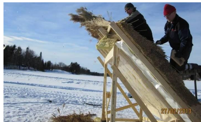
Joonis 3.33. Petri Iivonen käpaga harja tasandamas
