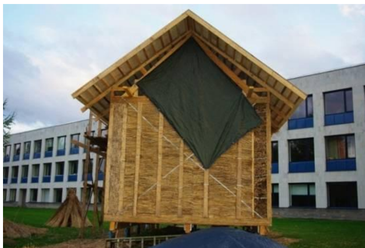
Joonis 3.20. c Sein VS-3 (pilliroo paneelsein)
