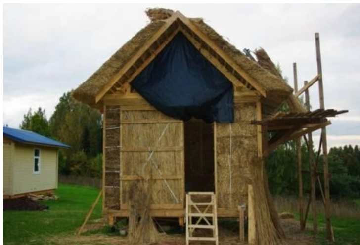
Joonis 3.20. a Sein VS-1 (vertikaalpilliroosein)
