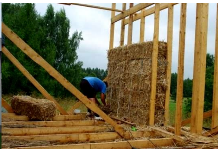
Joonis 3.20. d Sein VS-4 (pilliroopakisein)
