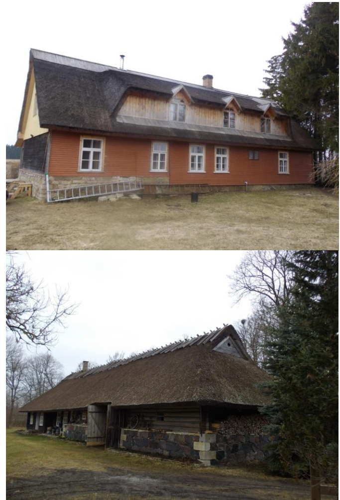
Joonis 3.38. Uuritud hooned. Ülal haavalaudadega kaetud roogkatuse hari ja all kelpkatus traditsioonilisel moel harjamalkadega kinnitatud harjaga ja kelbas oleva unkaauguga (fotod: S. Sõber)
