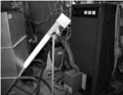
Joonis 4. Katel Pelle pelletipõletit ja kütusemahutiga.
