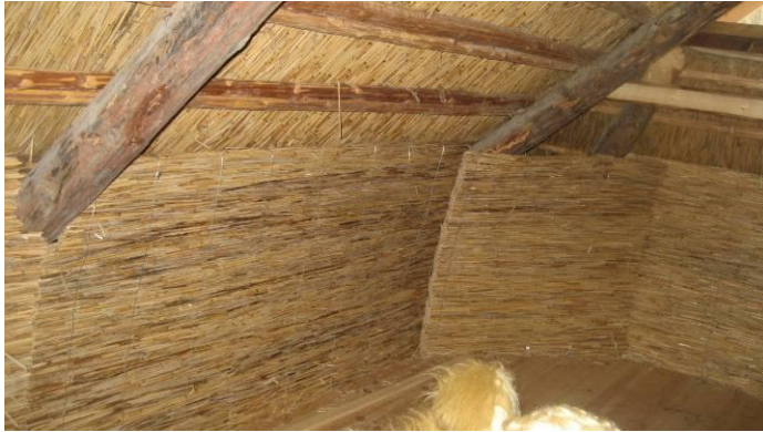
Joonis 3.43. Korralikult soojustatud pööning (foto: S. Sõber)
