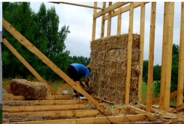
Joonis 3.20. d Sein VS-4 (pilliroopakisein)
