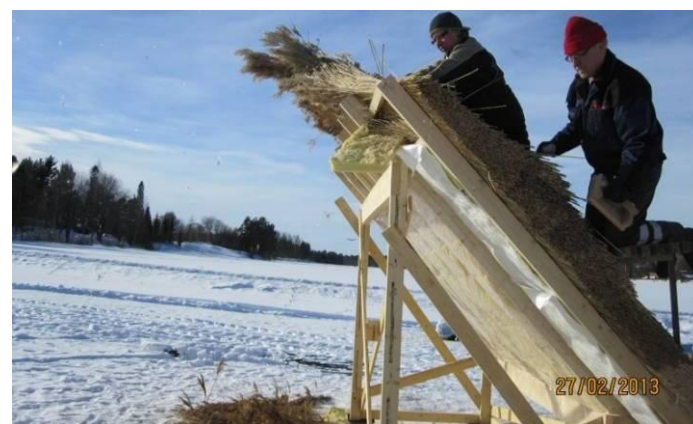
Joonis 3.33. Petri Iivonen käpaga harja tasandamas
