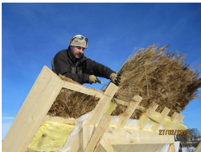
Joonis 3.34. Veli-Matti Saaren-Kierola üle harja ulatuvat roogu lõikamas (autori foto)
