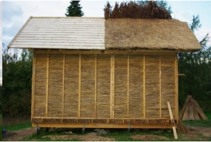
Joonis 3.20. b Sein VS-2 (horisontaalpilliroosein)
