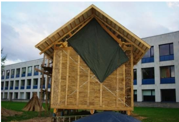
Joonis 3.20. c Sein VS-3 (pilliroo paneelsein)
