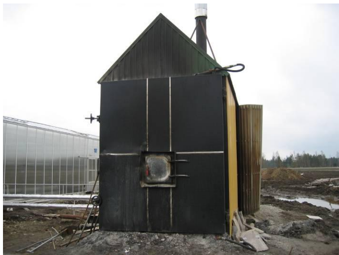
Joonis 4.6. Katel heina-/põhupallide ja -pakkide põletamiseks (foto: Ü. Kask)
