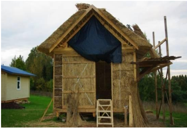
Joonis 3.20. a Sein VS-1 (vertikaalpilliroosein)
