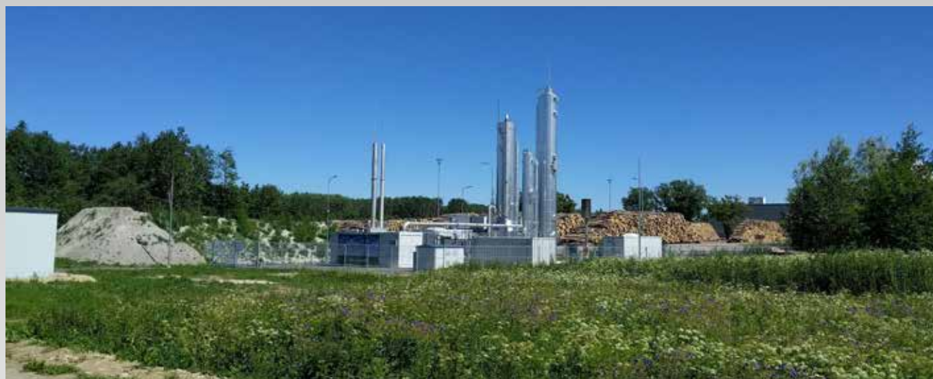
Osaühing Rohegaas toodab biometaani Kundas asuva haavapuitmassitehase reoveesetest.
