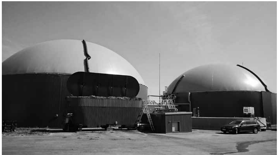
Foto 1: Biogaasikääritid, ees tahemassi vastuvõtu konteiner.
