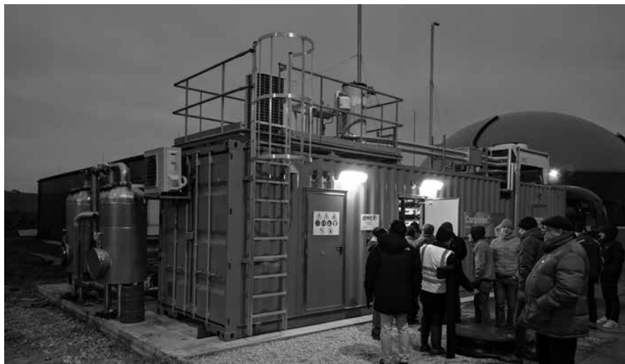
Biogaasi puhastustehas Koksveres. Biogas purification facility in Koksvere.
