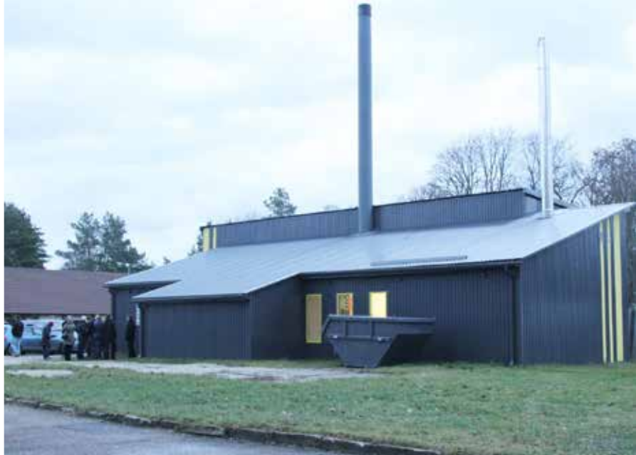
AS-i SW Energia Uulu renoveeritud katlamaja. Renovated boiler house in Uulu belong to SW Energia OÜ.
