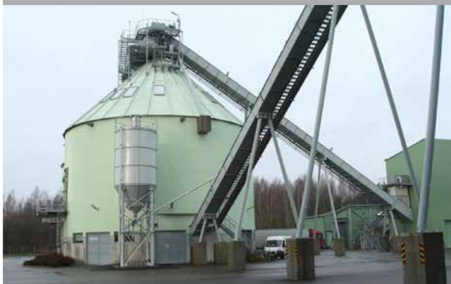
Kinnine kütuseladu AS-i Fortum Eesti Pärnu soojuse ja elektri koostootmisjaamas. Fully closed fuel storage at AS Fortum Eesti in the Pärnu Heat and Power Cogeneration Station.
