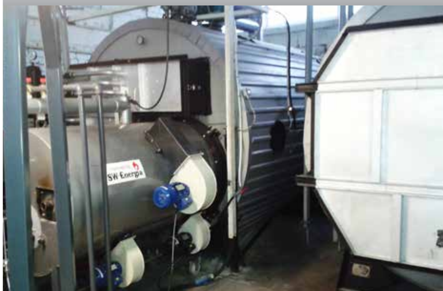
Pelletiküttele üle viidud ja renoveeritud Kiviöli 80 tüüpi katel OÜ SW Energia Paikuse katlamajas.
