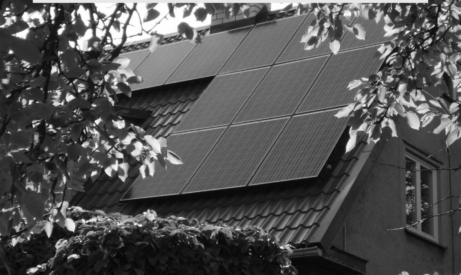
3,3 kWp päikeseelektrijaam Tallinnas. Solar power station with capacity 3.3 kWp in Tallinn.
