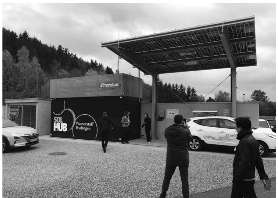
Froniuse tankla, mis on võimeline tootma, salvestama ja väljastama rohelist vesinikku.
