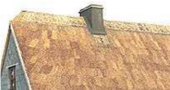
Joonis 3.22. Lame hari ( flush ridge ) (foto: Thatchco ... 2013)
