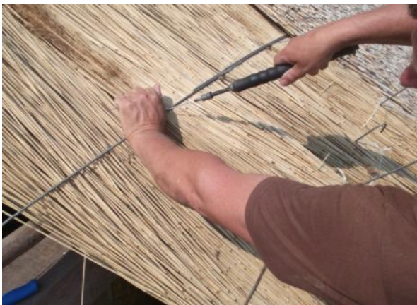
Joonis 3.10. Eelmise ja järgmise korralati jätkamine ja pingutamine (foto: J. Miljan)
