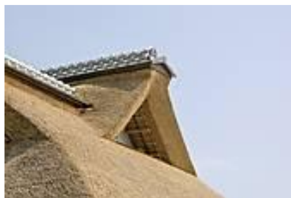
Joonis 3.28. Metalliga fikseeritud roogkatuse hari Jaapanis (foto: Photosearch 2013:2)
