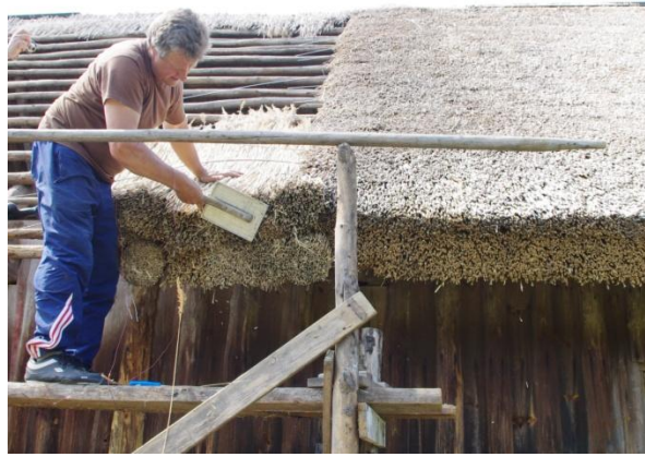
Joonis 3.5. Räästasse paigaldatakse roog tellingutelt (foto: M. Miljan)
