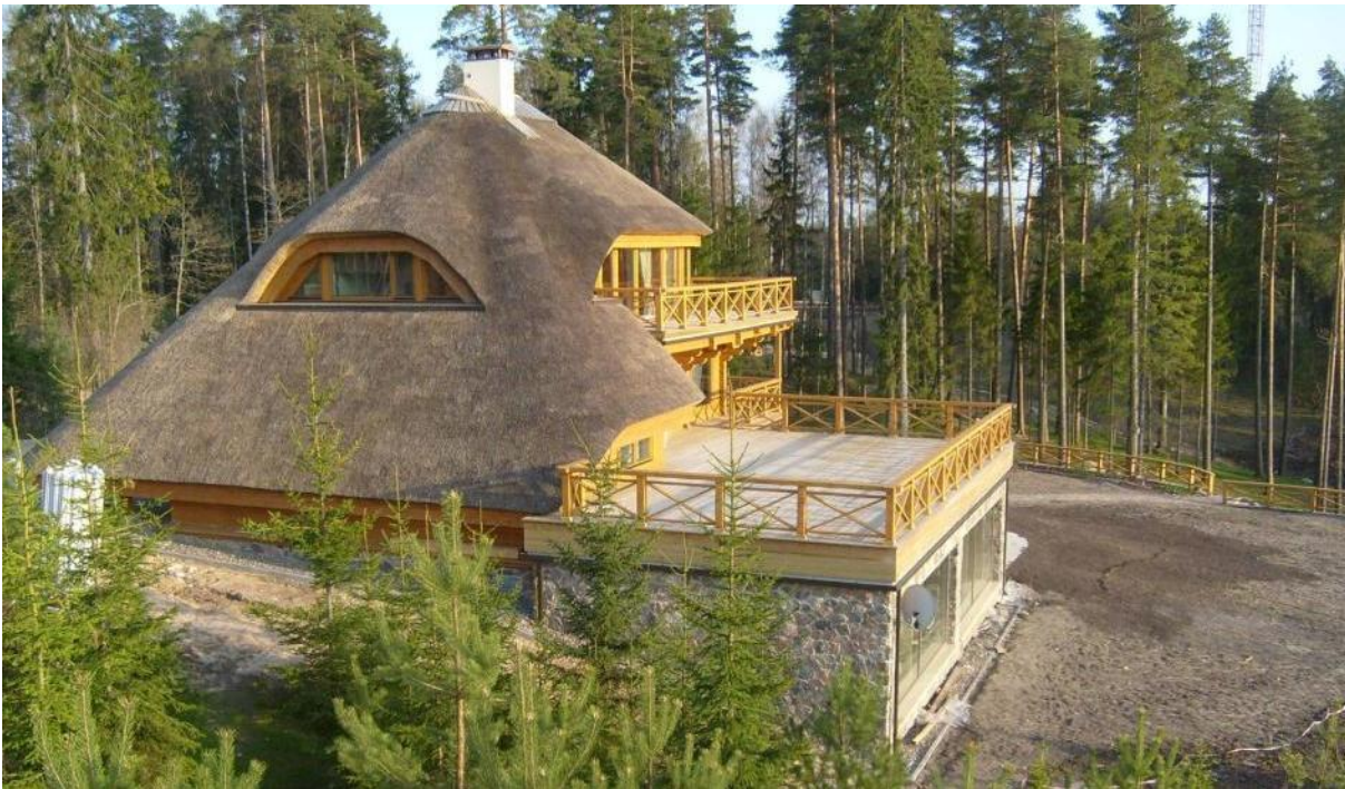
Joonis 3.12. Moderne roogkatusega elamu Lätis Amacemsis, mille hari on kaetud laudadega (foto: J. Miljan)
