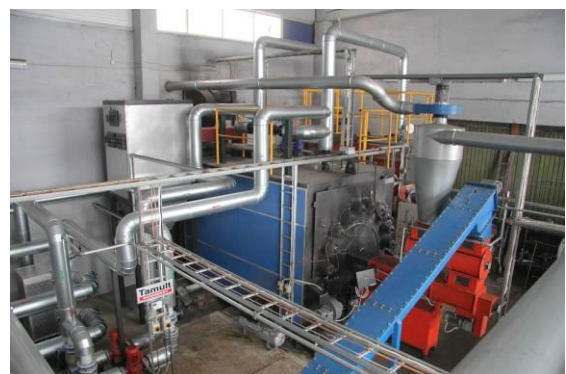
Joonis 6.6. Heina ja pilliroo lintransportöör (vasakul) ja Danstokeri biomassi katel (paremal) Lihula katlamajas (foto: Ü. Kask)
