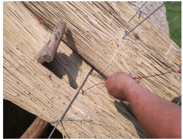
Joonis 3.9. Kiilu kasutamine sidumistraadile vahe tegemiseks tihedasti kokku surutud rookõrte vahele (foto: J. Miljan)
