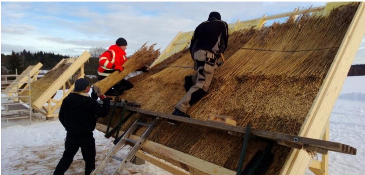
Joonis 3.43. Roogkatuste ehitamine põletamise katseks Soomes (R. Lautkankare 2013)
