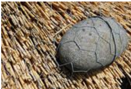
Joonis 3.15. Katuseroo kinnitamine tuulisel alal (foto: Photosearch 2013:88)
