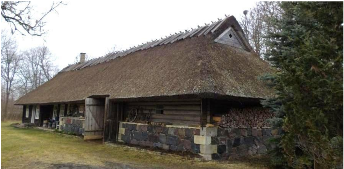
Joonis 3.14. Harjamalkadega fikseeritud ja unkaauguga kelpkatus (foto: S. Sõber)
