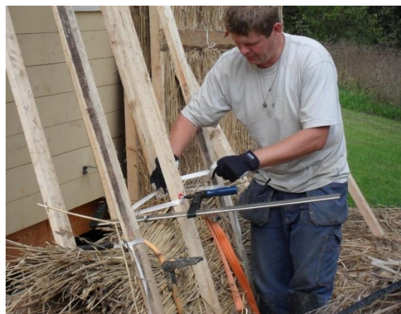
Joonis 3.59. Seinapaneelide karkassi väljanõtkumise takistamiseks kasutatakse meister Knut Kleis pressimise ajal pitsituskruvisid (foto: J. Miljan)
