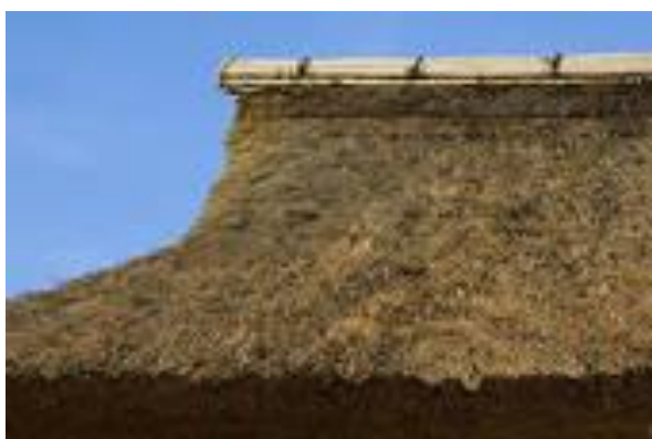
Joonis 3.27. Bambuslattidega kinnitatud roogkatuse hari Jaapanis (foto: Photosearch 2013:1)
