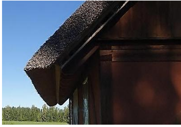
Joonis 3.17. Eesti jaoks ebatraditsiooniline kanarbikuga kaetud katusehari ja räästajoon, mis ei ole katusel olevate rookõrte suunaga risti (foto: T. Pitkänen)
