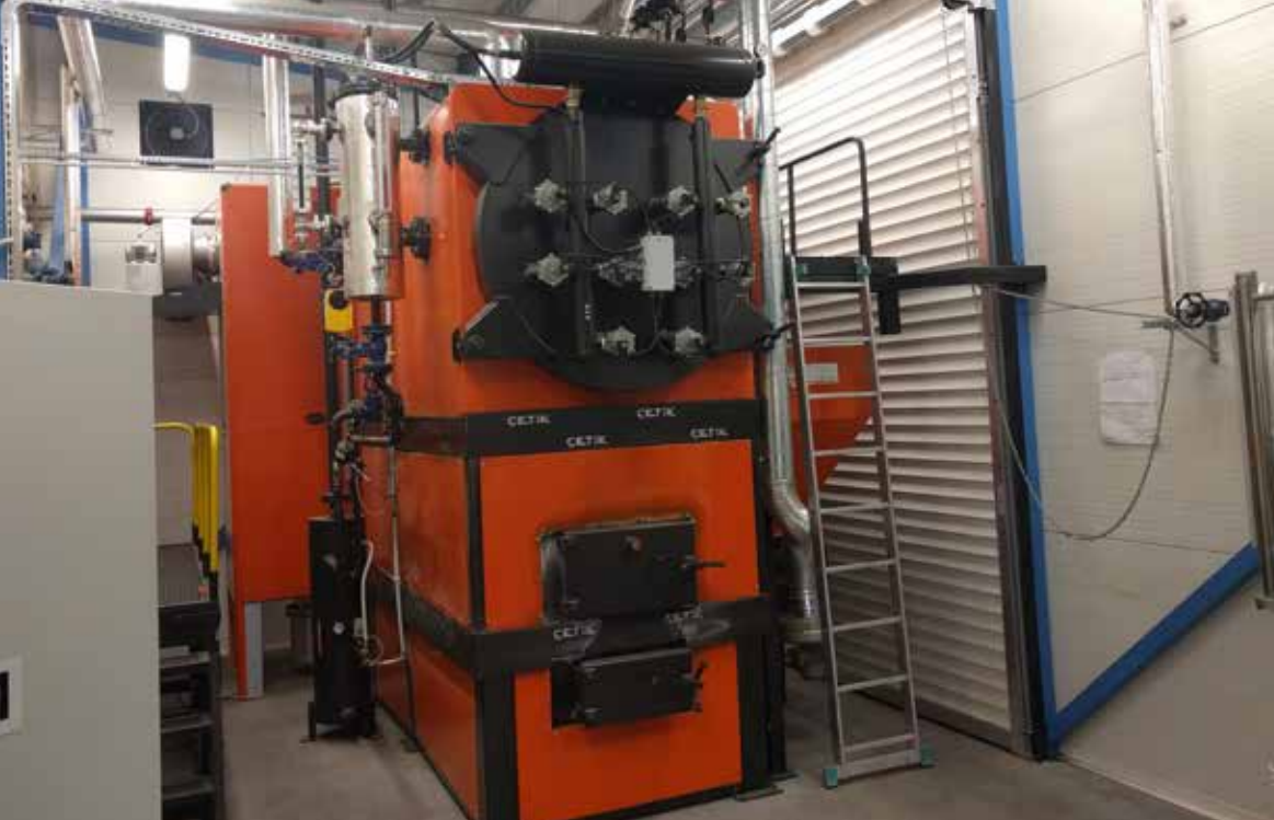
Aurukatel Stora Enso Imavere puidugraanuli-tehases. Auru vajatakse graanulite tootmise protsessis.
