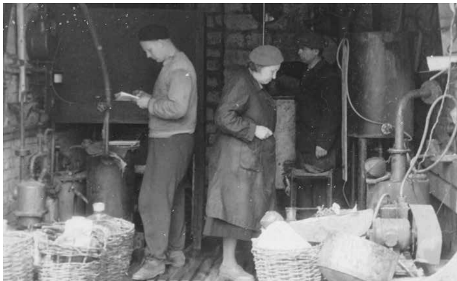
Dikarboksüülhapete pilootseade Kiviõlis. Sektori juhataja Aleksandra Fomina oksüdatsioonikatset jälgimas, Rein Veski näite kirjutamas ja Aleksandr Iljin ventiili abil käsitsi rõhku reaktoris vajalikul tasemel hoidmas. Vasakul on kaitsekilbi varjus 74-liitrine oksüdatsioonireaktor ja esiplaanil lämmastikhappe „ladu“, paremal diklooretaaniga ekstraheeritavate toordikarboksüülhapete vaakumdestillatsiooniseade.
