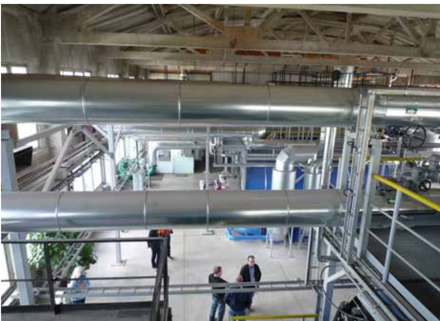
Sisemiselt uuendatud Võrusoo katlamaja. Reconstructed Võrusoo boiler house.
