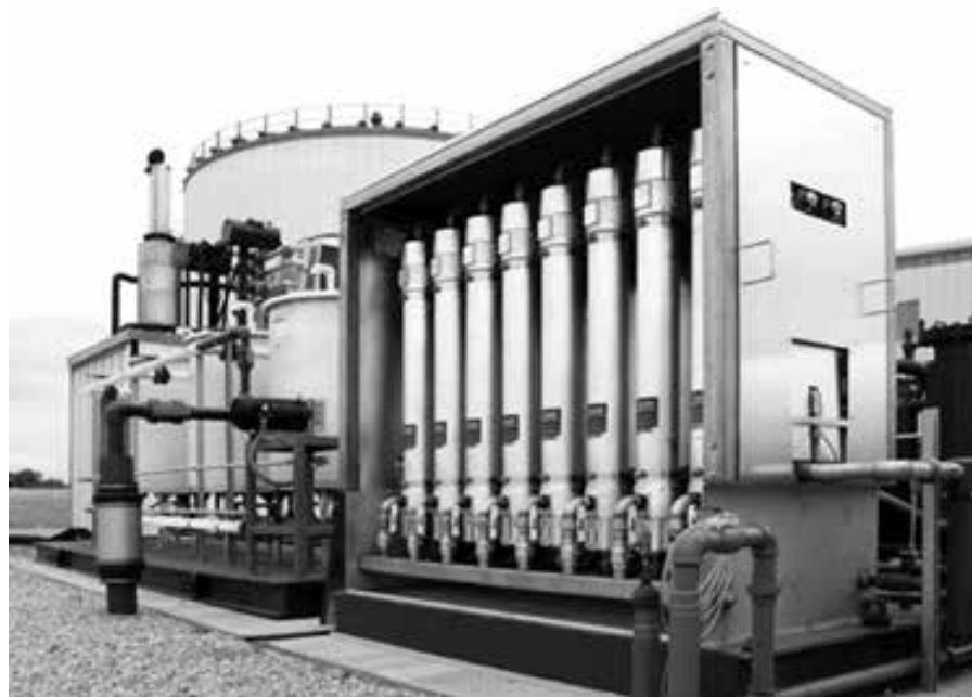
Joonis 5. Membraanpuhastusseade. Tootlikkus 100–1000 Nm 3 /h.
