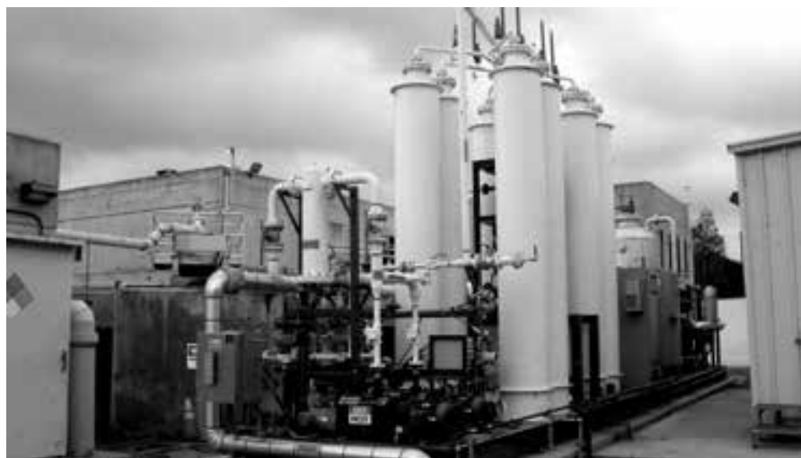
Joonis 1. Kõikuvrõhuadsorber Escondido reoveepuhastusjaamas, Californias, suudab varustada gaasiga 1200 majapidamist.
