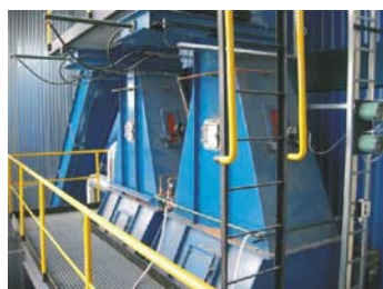
10-MW mehaanilise restkolde kütuse hüdraulilised sissesöötid
