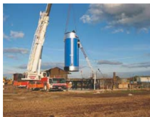
35-tonnise kaaluga katla montaaž
