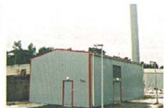
Tallinna Tehnikaülikooli 7,02 MW katlamaja
