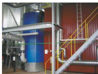
3,5-MW Danstokeri vertikaalne veekatel ja 4,2-MW restkolle
